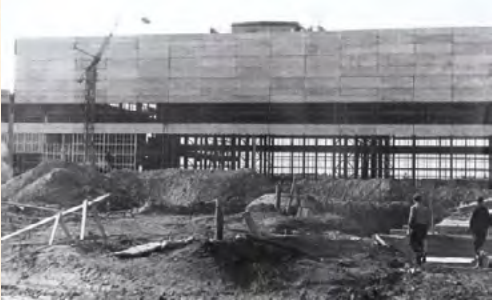
Строительство главного корпуса завода
